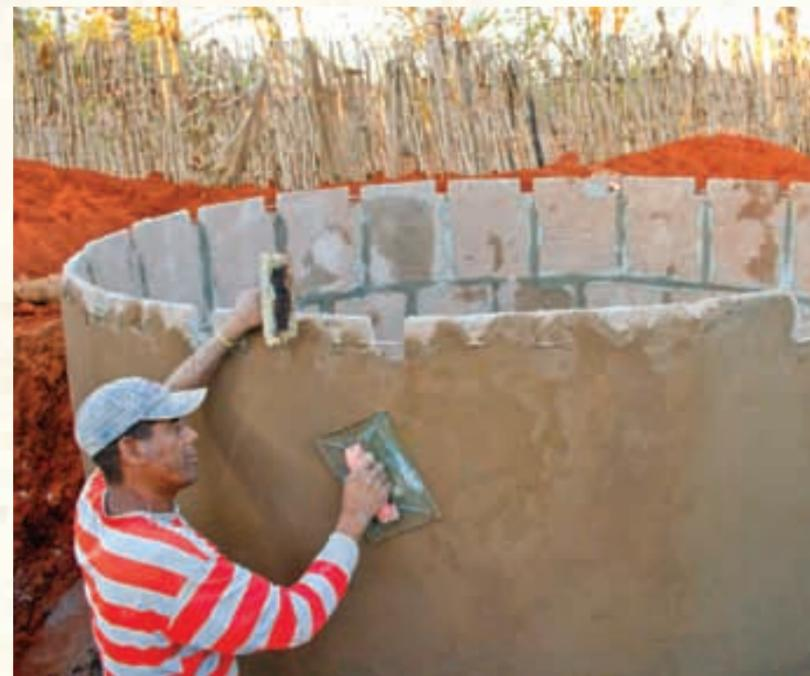
No sistema implantado nas escolas, uma cisterna de consumo abastece as torneiras com água da chuva, captada por calhas próximas aos telhados. Uma cisterna de produção recebe a água da enxurrada, que é utilizada para irrigar hortas escolares.
